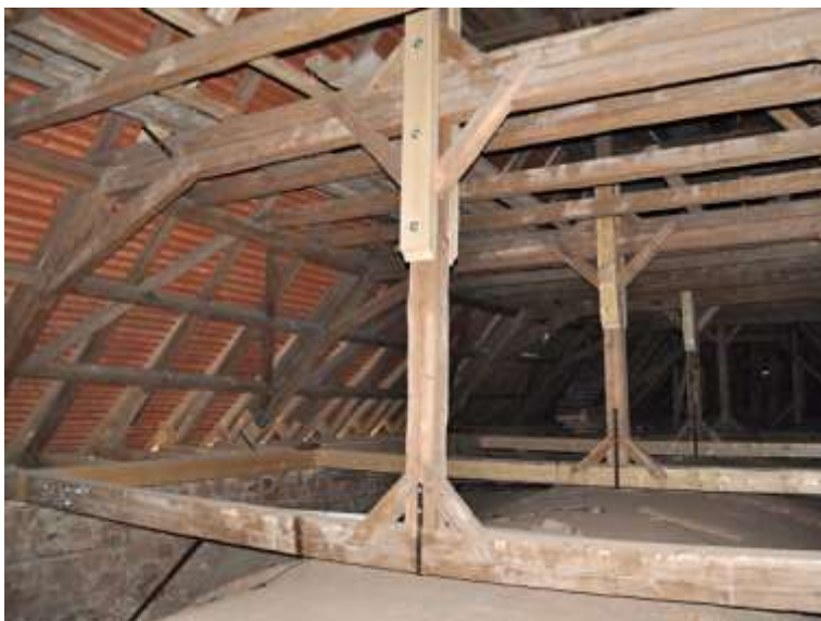
Dubnice, kostel Narození Panny Marie po opravách krovu a pokládce nové krytiny v roce 2013. Na dolním obrázku je detail krovu.
