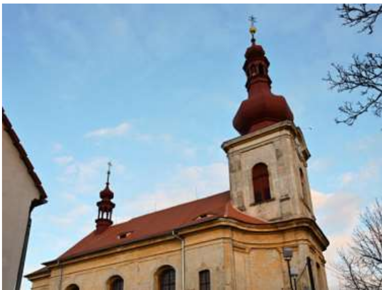
Holany, kostel sv. Maří Magdaleny po opravách střechy a korunní římsy na jižním průčelí v roce 2013.
