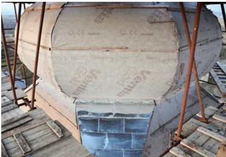
Brenná, kostel sv. Jana Křtitele, bábň střechy věže připravená pro oplechování v roce 2013.
