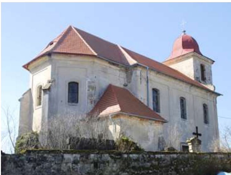
Bořejov, kostel sv. Jakuba po dokončení opravy střechy v roce 2009.
