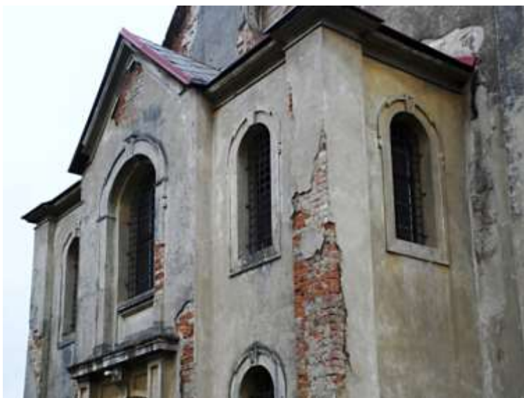
Dobranov, kostel sv. Jiří, předsíň s mřížemi osazenými v roce 2009.
