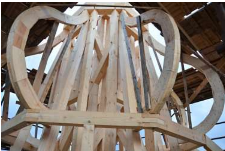
Brenná, kostel sv. Jana Křtitele, stavba krovu cibulové bání věže v roce 2012.
