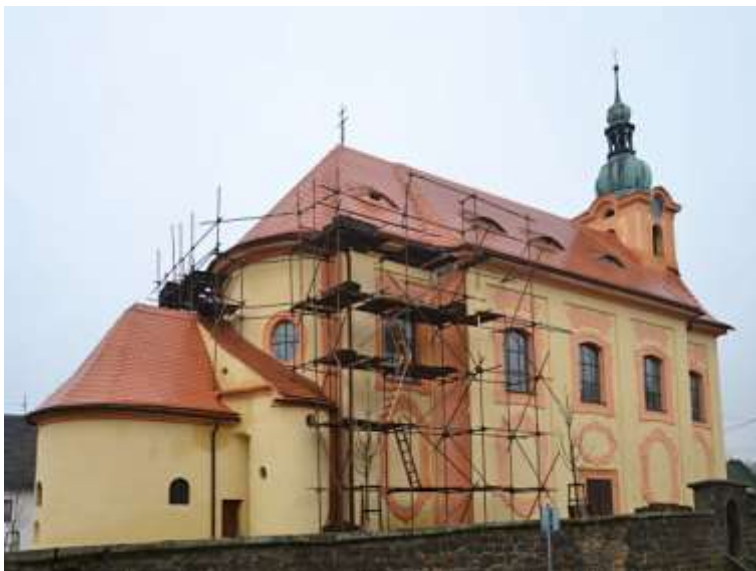
Kvítkov, kostel sv. Jakuba po dokončení obnovy fasád a položení nové střešní krytiny v roce 2012.
