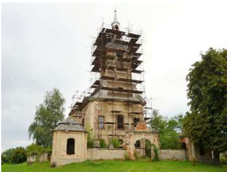
Brenná, kostel sv. Jana Křtitele, dokončená horní část střechy věže v roce 2013.
