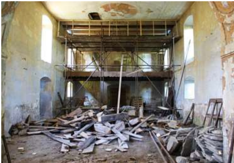
Volyně, interiér kostela sv. Petra a Pavla při opravě krovu lodi v roce 2013.
