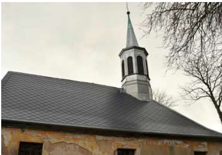
Volyně, kostel sv. Petra a Pavla po opravě střechy lodi v roce 2013.
