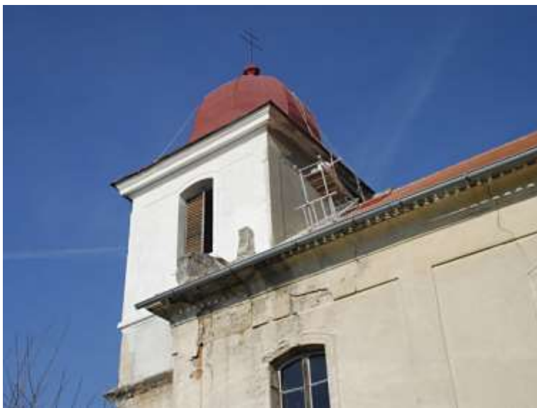
Bořejov, kostel sv. Jakuba při obnově omítek věže v roce 2010.
