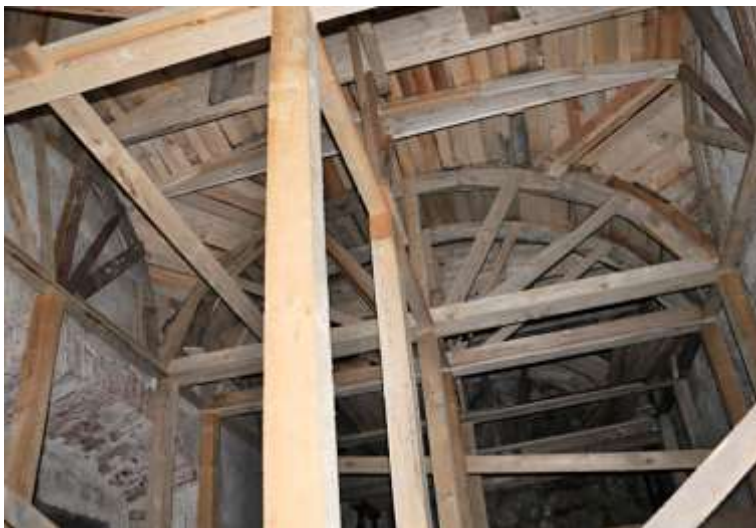
Stvolínky, kostel Všech Svatých po opravě střechy severní kaple v roce 2011. Na dolním obrázku je detail bednění pro rekonstrukci kleneb severní kaple.
