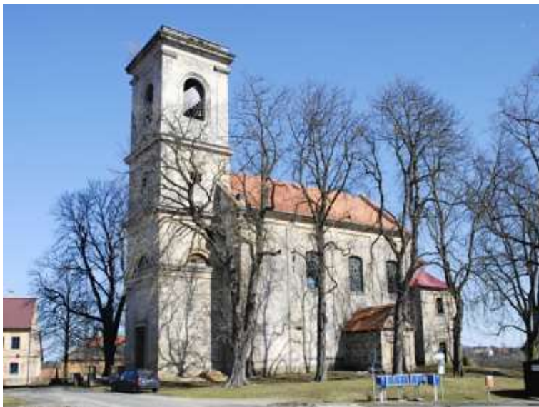
Pavlovice, kostel Nanebevzetí Panny Marie po dokončení opravy střechy v roce 2009.
