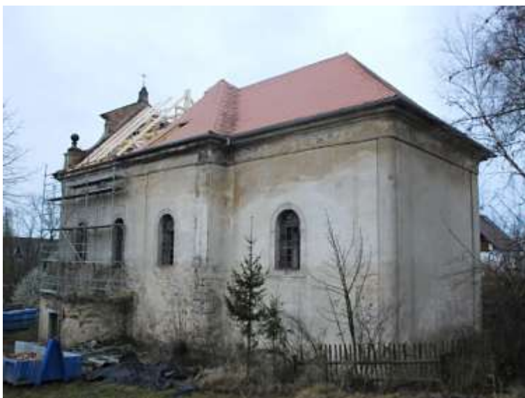
Kruh, kostel sv. Vojtěcha při dokončování stavby nového krovu v roce 2009.
