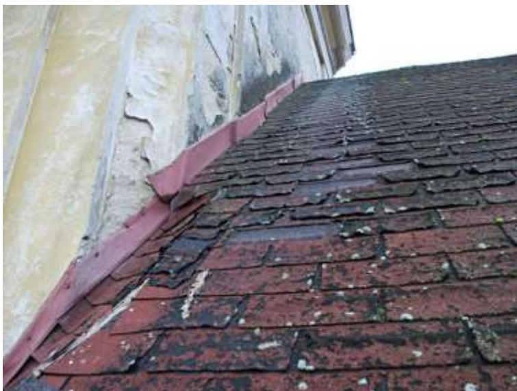
Holany, kostel sv. Maří Magdaleny, stav krytiny na počátku roku 2010.
