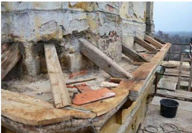
Holany, kostel sv. Maří Magdaleny, oprava korunní římsy na jižním průčelí v roce 2013.
