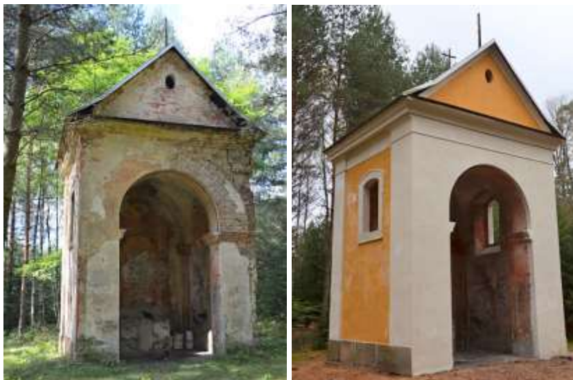
Boreček, kaple sv. Huberta, sv. Eustacha a sv. Jiljí - stav před obnovou a po obnově fasády v roce 2013 (všechna foto M. Panáček 2009–2013).
