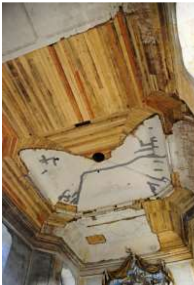
Brenná, kostel sv. Jana Křtitele po dokončení opravy krovu stropu v roce 2009.
