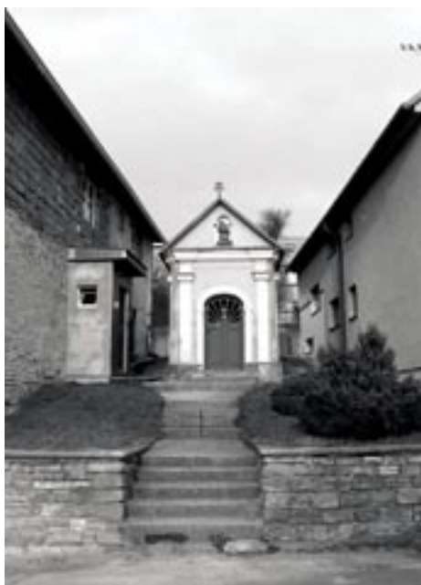
Kaple sv. Spasitele (ulice Fryčovická, mezi domy čp. 111 a 112)
