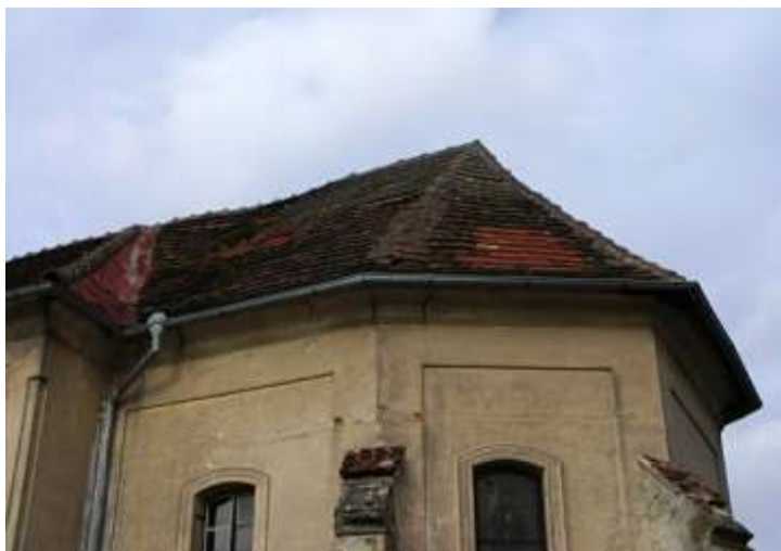
Bořejov, kostel sv. Jakuba Většího, pohled na poškozenou střechu presbytáře.
