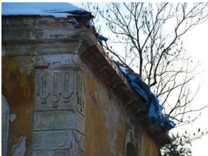
Stvolínky, kostel Všechn Svatých, nově vyzděná římsa.
