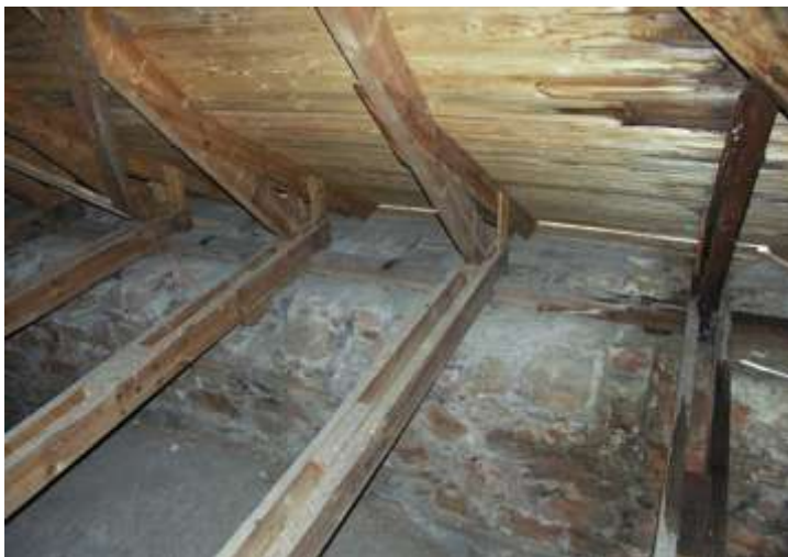
Kruh, kostel sv. Vojtěcha, krov provizorní střechy presbytáře.
