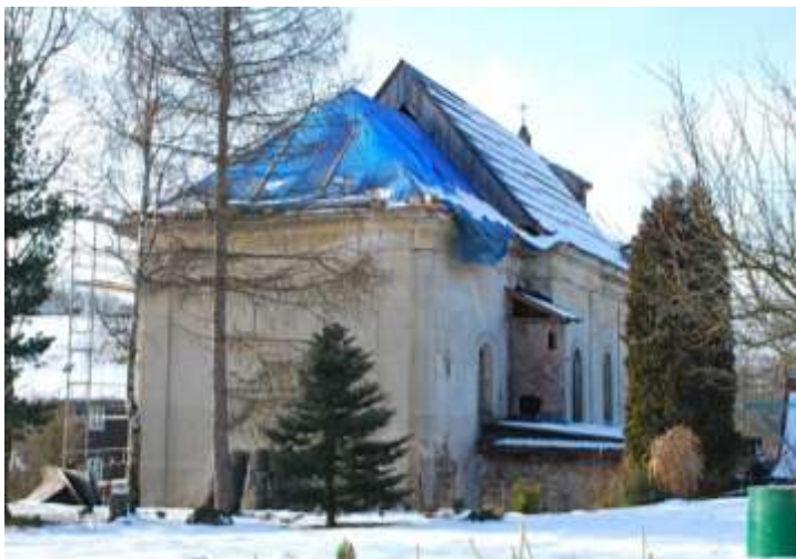
Kruh, kostel sv. Vojtěcha, provizorní zakrytí nového krovu presbytáře.
