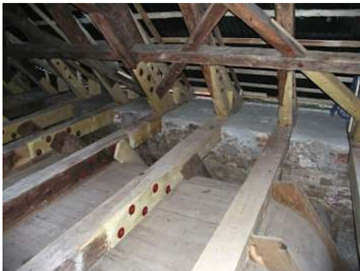
Brenná, kostel sv. Jana Křtitele, tesařsky opravený krov a strop kostela.
