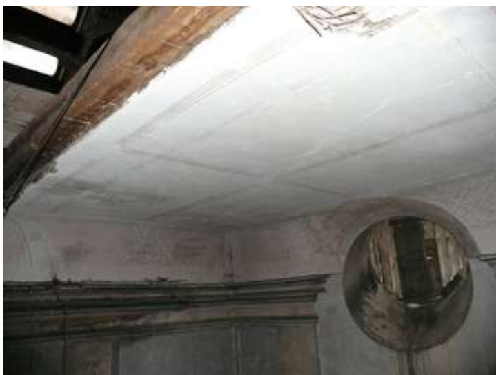
Brenná, kostel sv. Jana Křtitele, pohled na neporušený podhled stropu.
