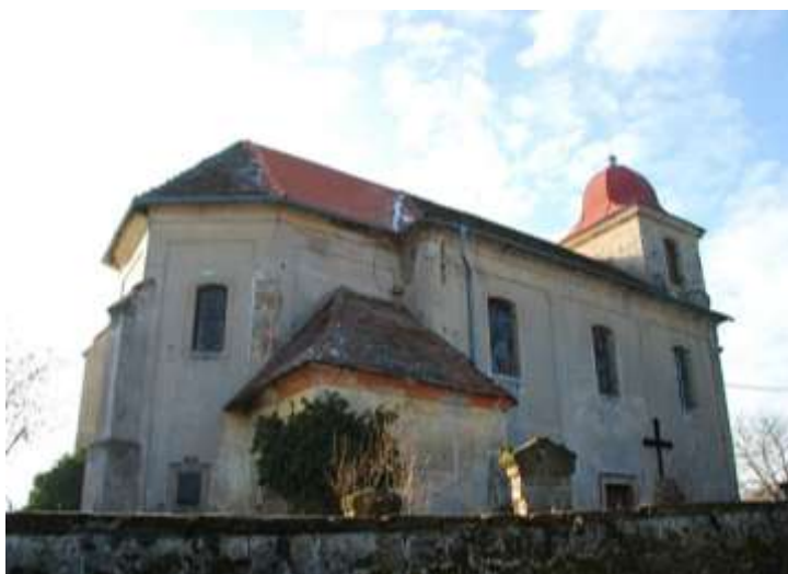
Bořejov, kostel sv. Jakuba Většího, pohled na kostel po opravě části střechy presbytáře.
