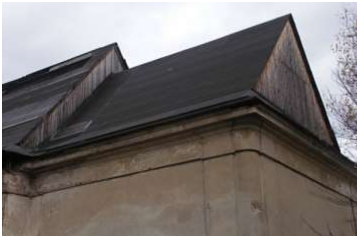
Kruh, kostel sv. Vojtěcha, pohled na provizorní střechu presbytáře.
