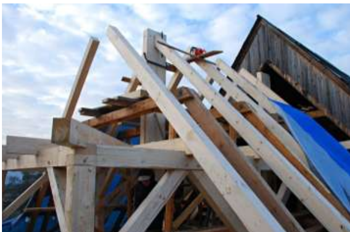
Kruh, kostel sv. Vojtěcha, stavba nového krovu presbytáře.
