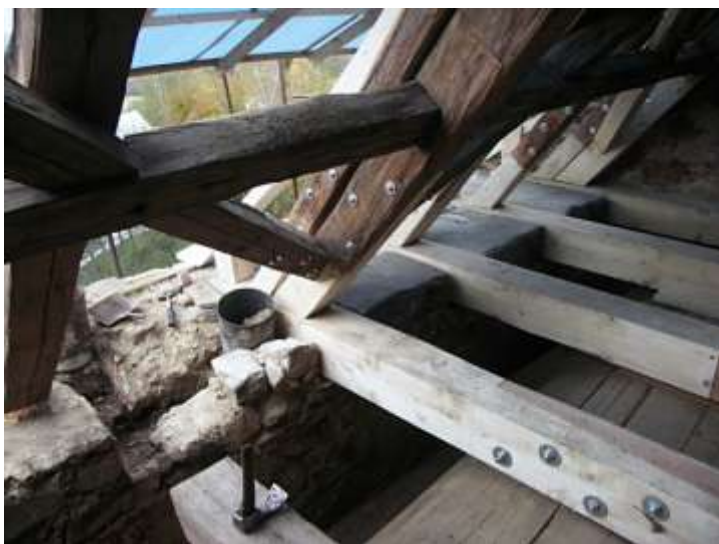
Brenná, kostel sv. Jana Křtitele, detail poškození původních prvků a tesařských oprav.
