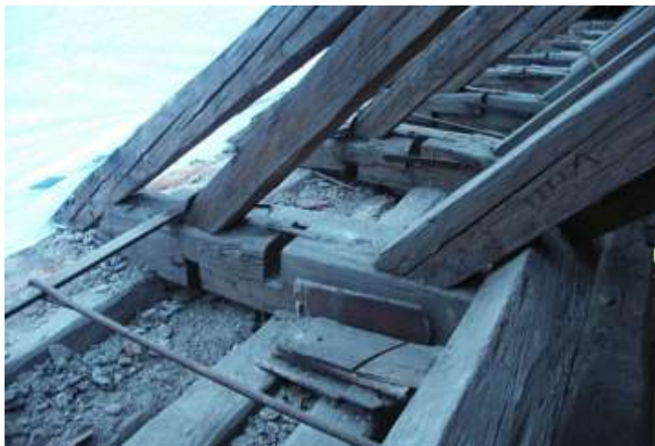
Stvolínky, kostel Všech Svatých, detail poškození krovu a koruny zdiva s římsou.
