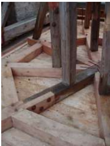
Drchlava, stav po opravě střechy v roce 2005. Pohled na opravený radiální prahový rošt stolice věžičky (vlevo) a opravené prvky podélné vazby krovu (vpravo).
