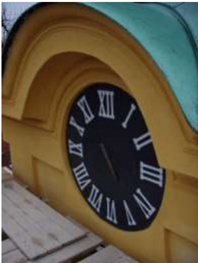
Kvítkov, kostel sv. Jakuba Většího. Vlevo je detailní pohled na opravené omítky věže a obnovený ciferník hodin, vpravo pohled na jižní fasádu lodi s téměř kompletně opadánými omítkami.
