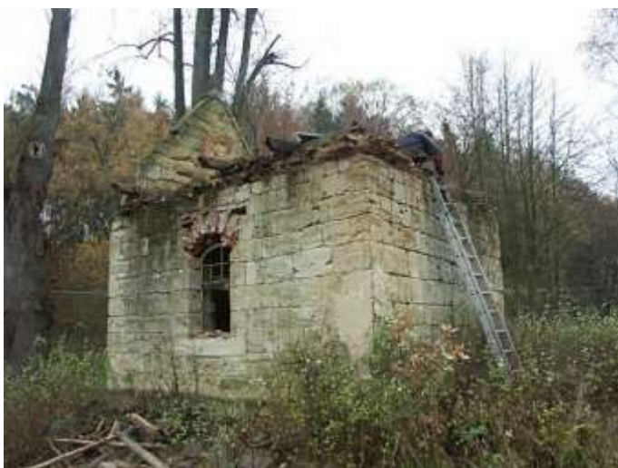
Kaple sv. Valentýna v Novém Šidlově před zahájením oprav (nahore) a po odstranění starého krovu 6.11.2005 (dole).
