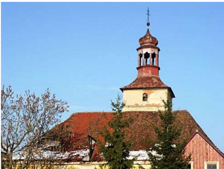
Stvolínky, kostel Všeoh svatých. Celkový pohled od jihu na počátku roku 2004.
