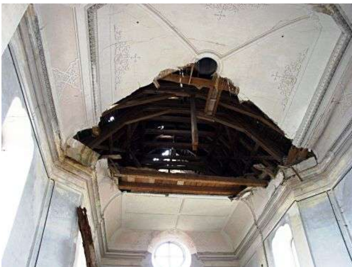
Brenná, kostel sv. Jana Křtitele. Pohled od východu na zřícenou část stropu, stav na počátku roku 2004.
