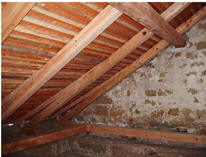
Drchlava, kostel sv. Mikuláše. Pohled od jihozápadu na nový krov sakristie, stav na konci roku 2004.
