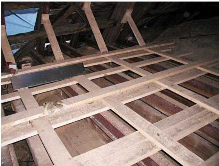
Brenná, kostel sv. Jana Křtitele. Pohled od severovýchodu do prostoru krovu na konstrukci vynášející část stropu hrozící zřícením, stav na konci roku 2004.
