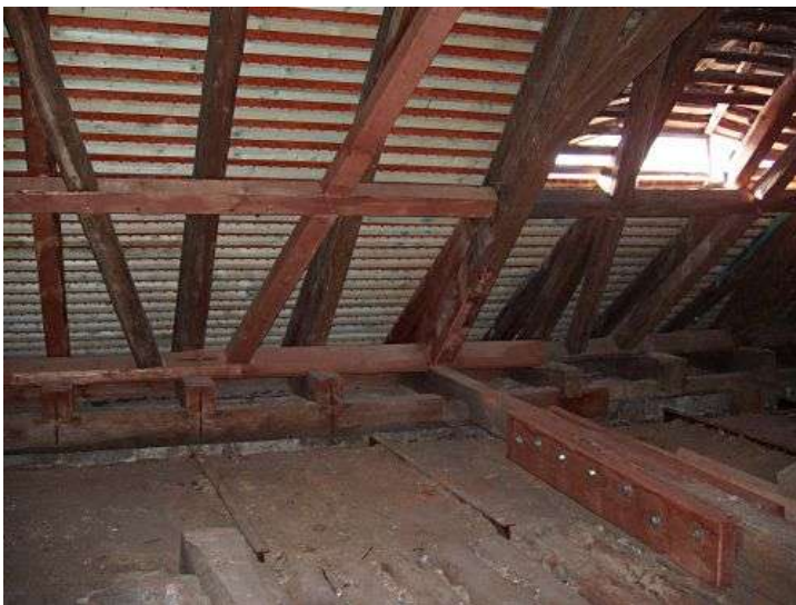
Stvolínky, kostel Všech svatých. Pohled od severu na jižní opravenou část vazby krovu, stav na počátku roku 2005.
